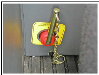
Seccionador de la batería
