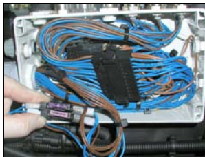
FV 1 Sensor de velocidad FV2 Medición longitudinal
